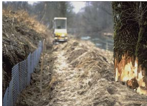
Ein Drahtgitter im Erdreich verhindert, dass der Biber seine Erdhöhlen oder Kanäle in die Uferböschung gräbt. (Foto Günter von Lossow)
