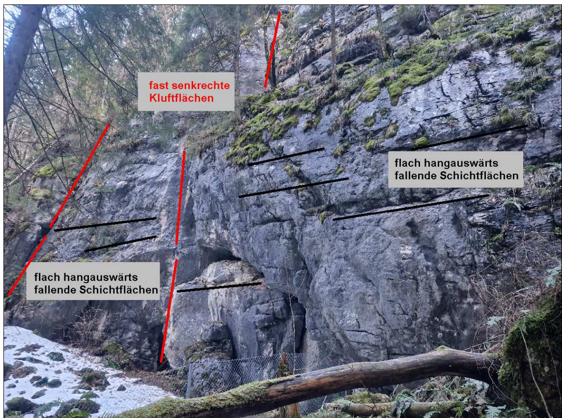
Abbildung 3: Trennflächengefüge im lagunären Dachsteinkalk oberhalb der Endstalquelle
